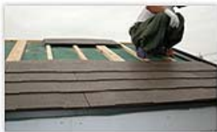
【屋根材施工状況】
